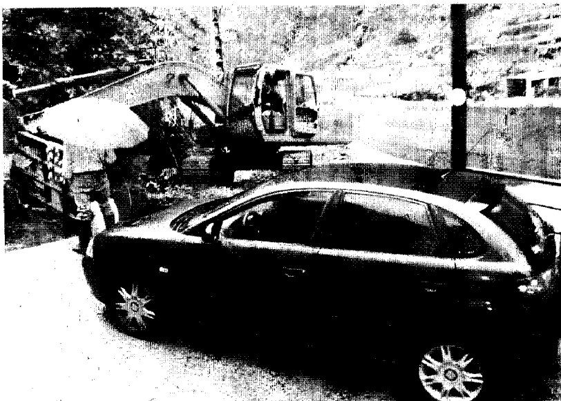
Um morador utilizou a sua viatura para impedir a saída da escavadora.
